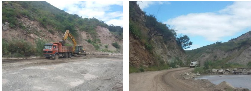
Carga de transporte de material a las zonas de stock
