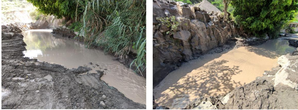
Piscinas de sedimentación
