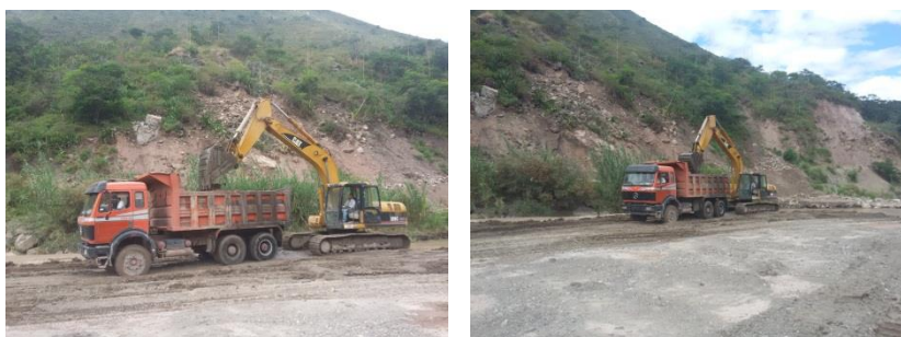
Carga de material a volquetes
