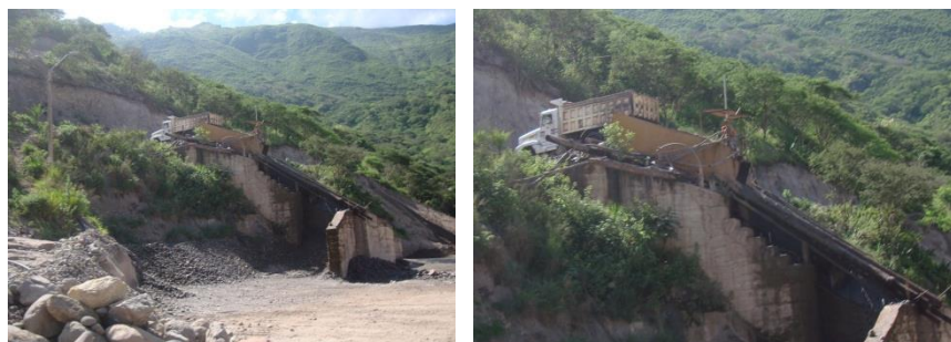
Volquetes descargando material planta de lavado hidráulico
